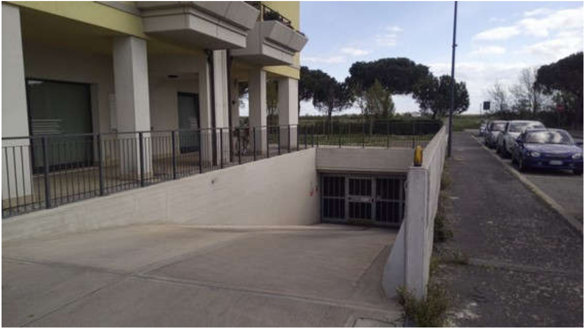
RAMPA ACCESSO GARAGE PIANO INTERRATO
