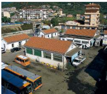
Attesa per i bandi. La cantina sociale abbandonata a Sambiasè (a sinistra) e la sede della Multiservizi in via della Vittoria (a destra)
