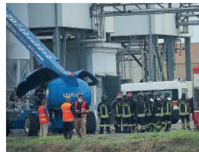
Esplosione. L'impianto esplose il 12 settembre 2013
