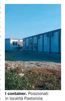
I container. Posizionati in località Pastorizia
