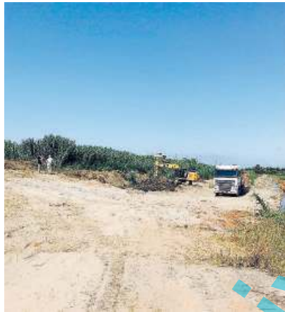
Ritardo storico. La Sant'Eufemia-mare in costruzione
