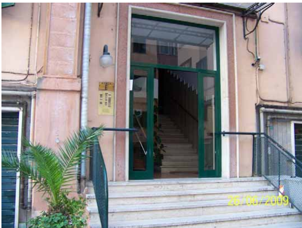
FOTO 2: L'ingresso della scala E dove è ubicato l'appartamento oggetto di causa.
