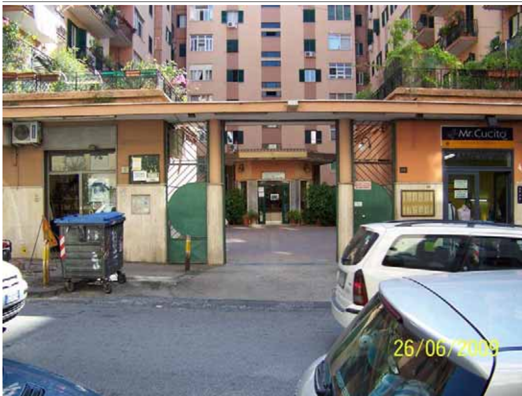
FOTO 1: L'ingresso del condominio di via S. Maria della Libera n. 13.
